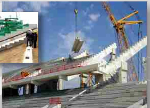
**Manipulación de prefabricado en hormigón**
