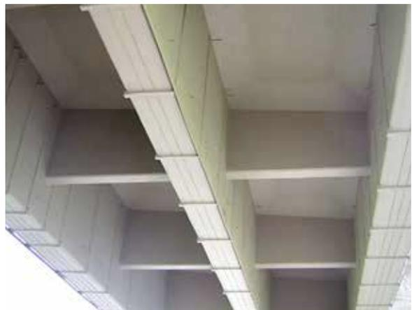
Puente reforzado con revestimiento de superficie protectora
