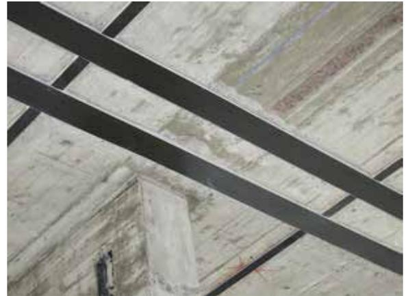
Laminados de fibra de carbón precurado
