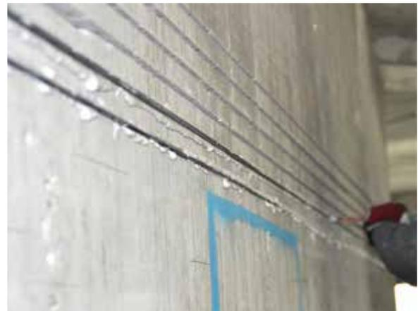
Laminados montados cerca a la superficie (NSM) (Near-Surface-Mounted Laminates)
